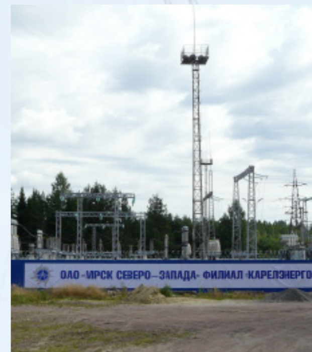
Новое ограждение установлено на ПС-25 «Питкяранта»
