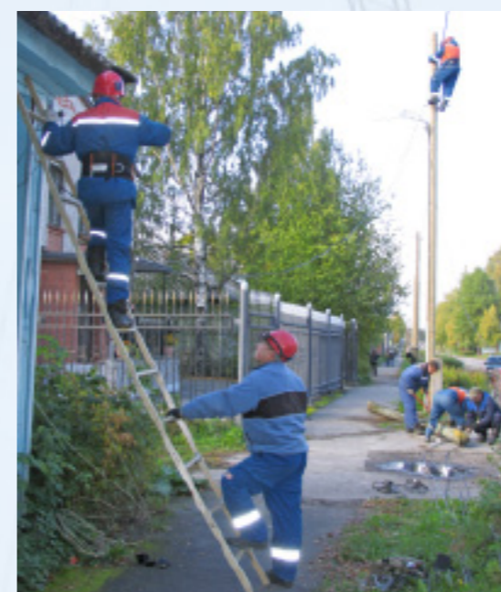
Ремонт линий электропередачи в городе Пудоже
