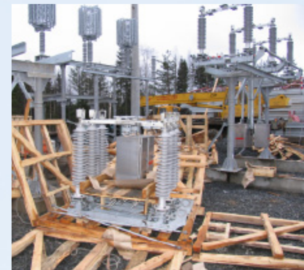
На строительстве РП 110 кВ в Ладве
