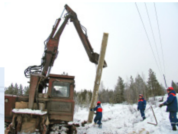
Ремонт воздушной линии в Беломорском районе
