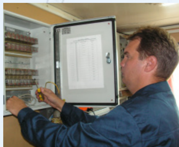
Монтаж системы телеуправления подстанцией
