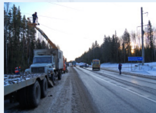
Восстановление энергоснабжения поселка Лучевой
