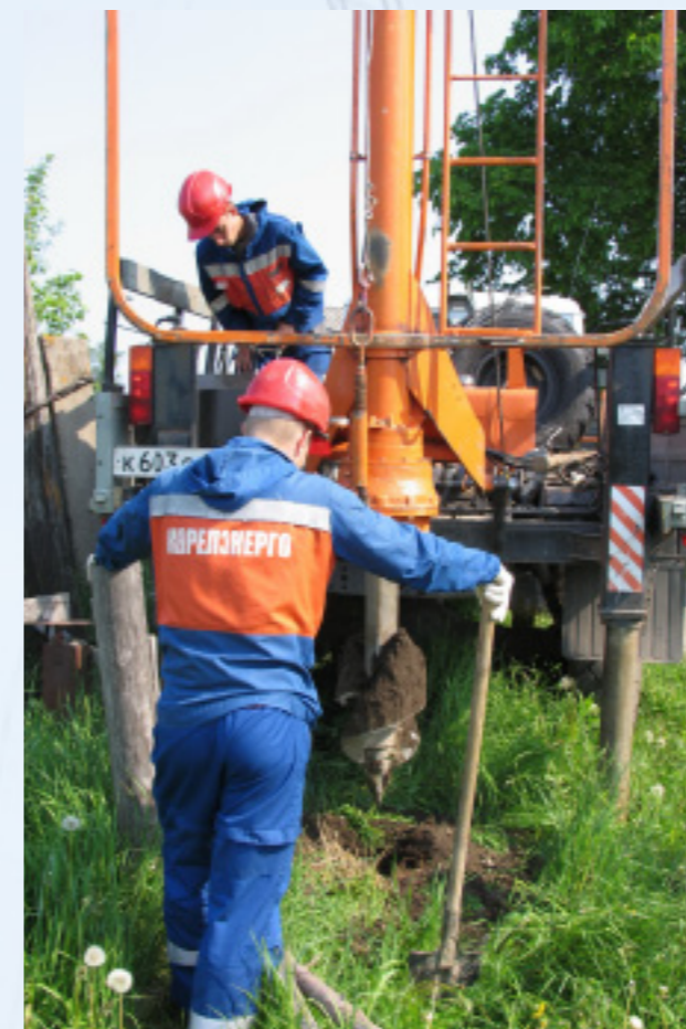
Бурильно-крановая машина в работе
