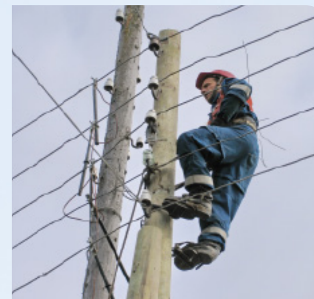
Монтаж оборудования ЛЭП
