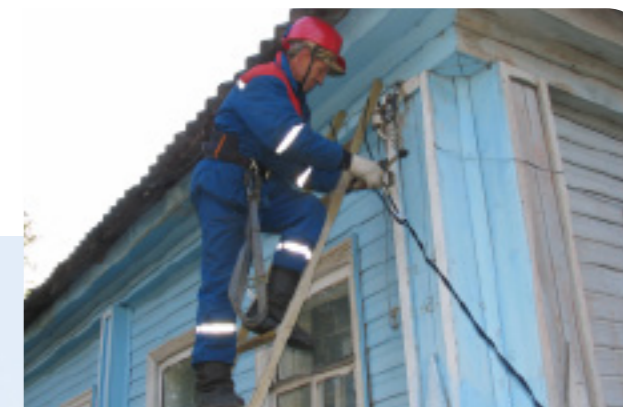
Монтаж оборудования на входе в жилой дом
