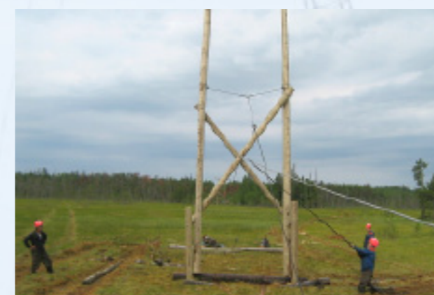
Новая опора установлена прямо посередине болота
