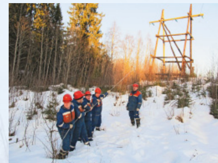
Бригада «Карелэнерго» ведет восстановительные работы на Л-58С в Сортавальском районе
