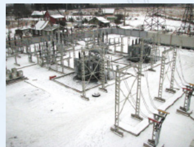
Реконструкция ПС-21 «Шуя»
