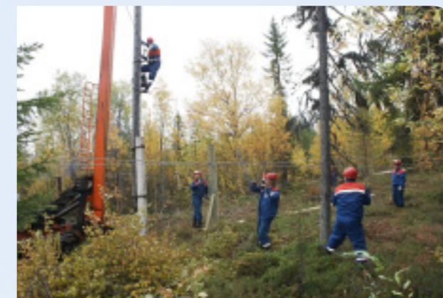
Подъем опоры на учениях
