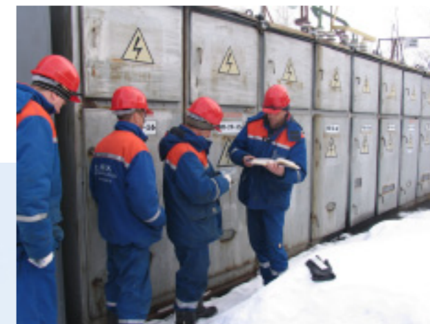
Допуск электромонтеров к работе на ПС 29к «Рабочеостровск»
